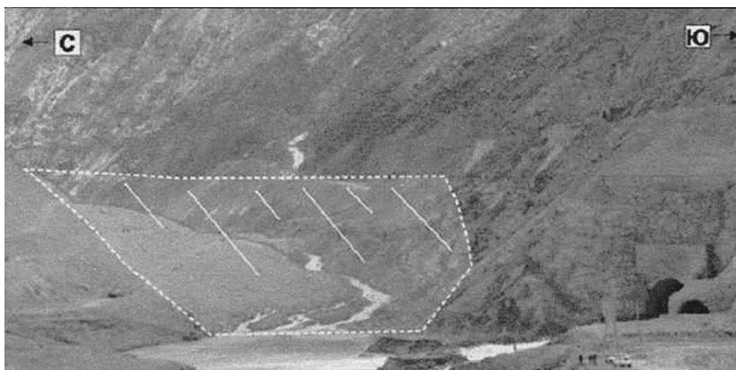
Рис. 1. Проектный (пунктирная линия) и фактический (красная линия) контур плотины КГЭС-2 после перекрытия р. Нарын с помощью КМВ
